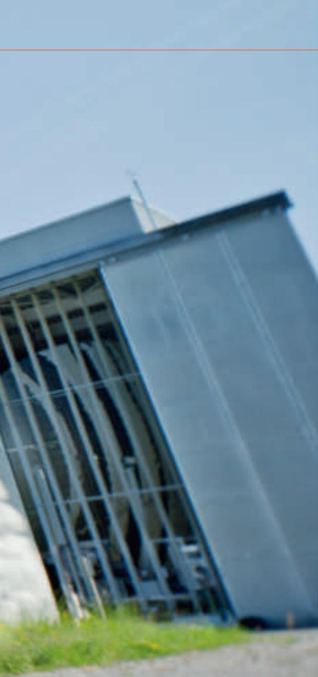
**Les miroirs de notre avenir.** Le four solaire de l'Institut Paul Scherrer (PSI) est capable de concentrer jusqu'à 5000 fois le rayonnement solaire. Cela permet de tester des réacteurs solaires à haute température. Photo: Derek Li Wan Po
