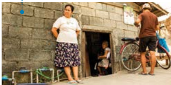
Las inundaciones dejaron cieno y barro frente a esta casa en Filipinas. Para una persona mayor con dispositivos de apoyo a la movilidad es difícil entrar y salir de casa.
