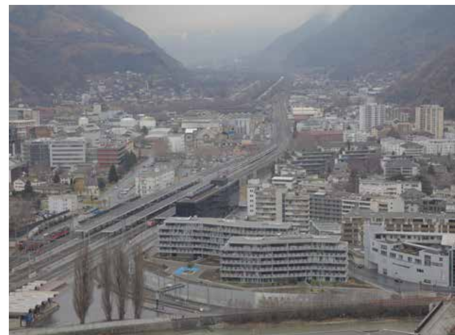
Ill. 31 Une planification et un aménagement manquant de sensibilité entraînent le mitage et la laideur
